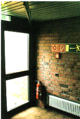
Bild 21: Notausgang in einem Verwaltungsgebäude
