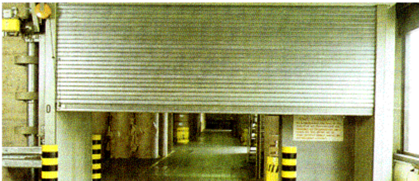
Bild 27: Selbstschließendes Feuerschutz-Rolltor
